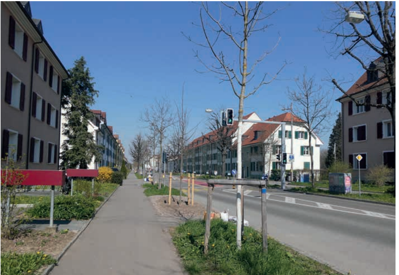
Oben: : Wer erinnert sich noch an die Fussgängerüberführung am Morgartenring? Im April 2012 wurde sie abgebrochen. Unten: Fussgängerüberführung mit Ampel, 2019
