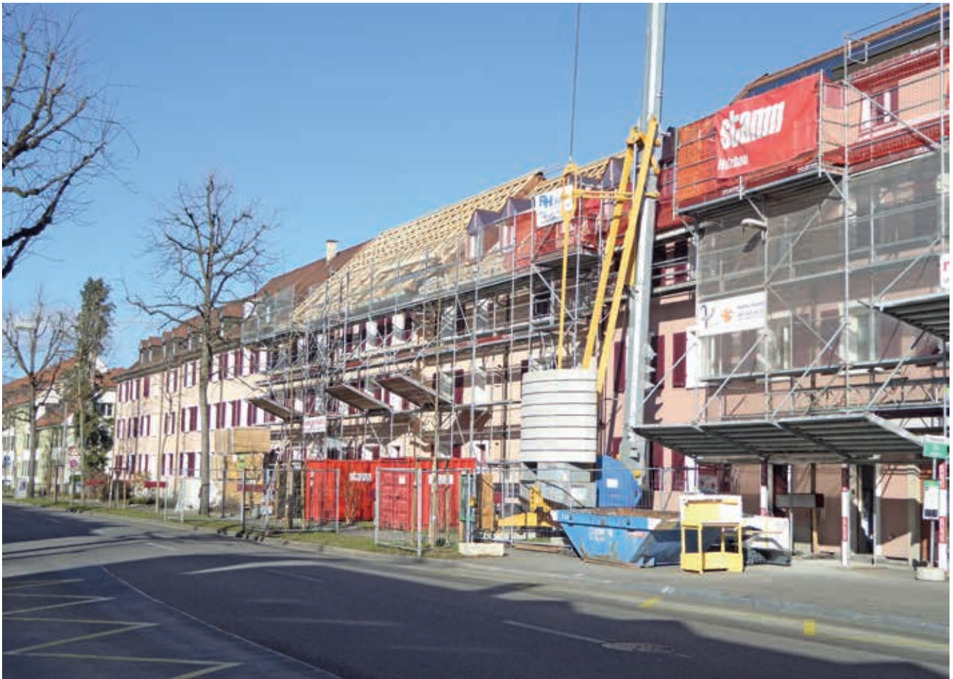
Oben: Sanierung Einfamilienhäuser Rigistrasse, 2010–2012 Unten: Sanierung Mehrfamilienhäuser Morgartenring, 2015–2017
